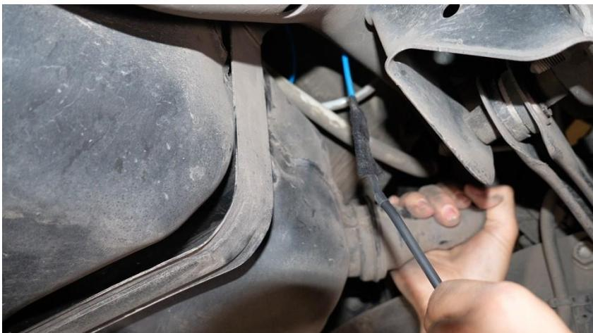
7. Die Kabel zu den Stellmotoren verlegen und gut befestigen (Kabelbinder).
