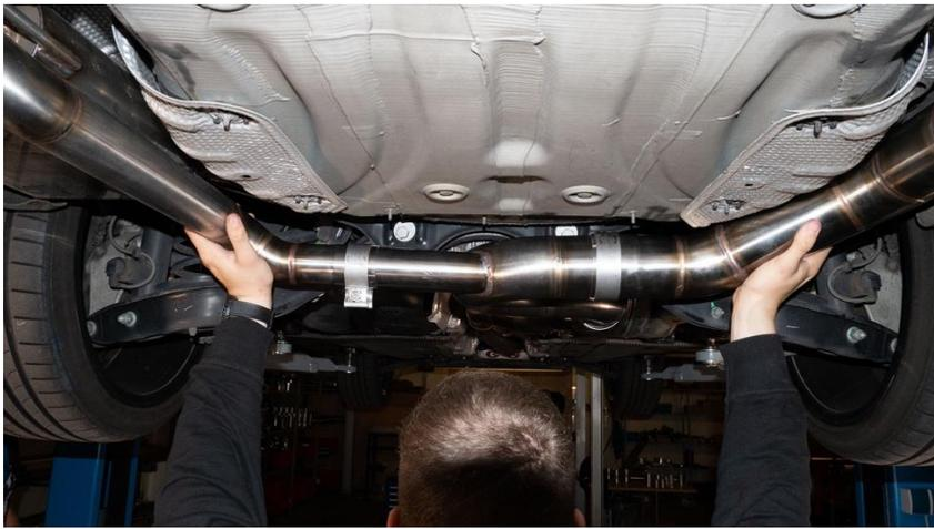
6. Die Schelle am Reduzierstück und am Mittelschalldämpfer anziehen.
